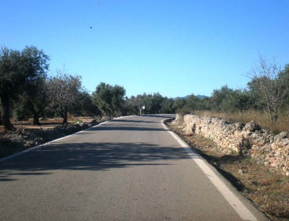
FOTO.01. -TRAMO 1.- Punto de inicio, entronque con la CV-100_
