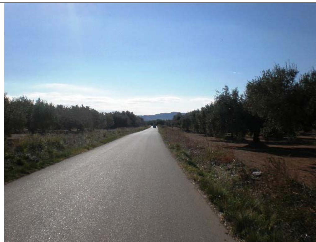
FOTO.04. -TRAMO 2.- Camino de la Espona -
