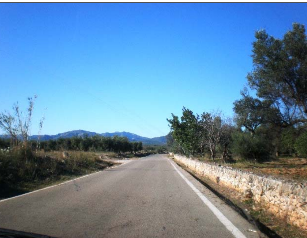
FOTO.02. -TRAMO 1.- Estado actual de la CV-100 -
