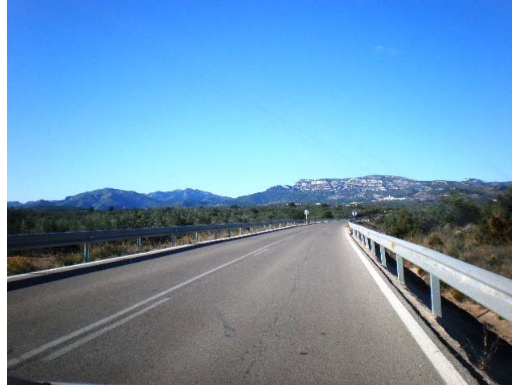
FOTO.03. -TRAMO 1.- Tramo mejorado de la CV-100 -
